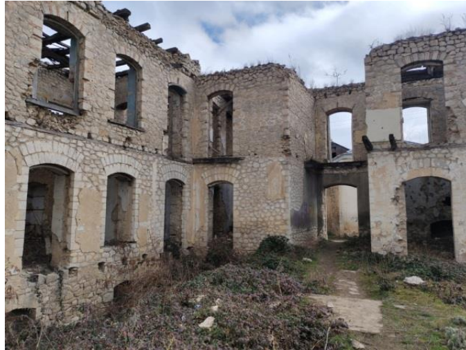
Şəkil 2.14. Şuşa,dağıdılmış ev
