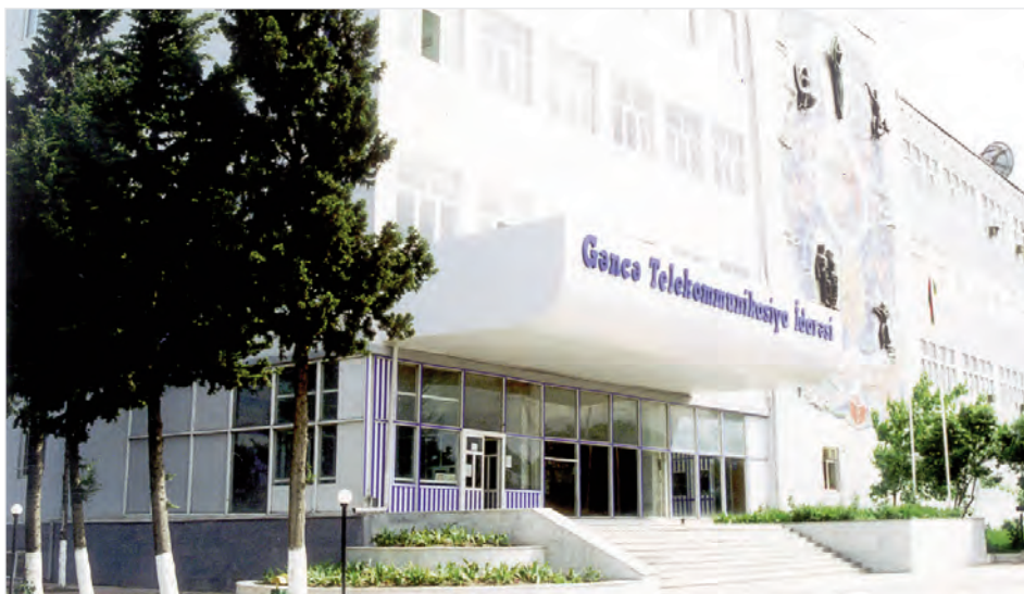
Здание Гянджинского Телекоммуникационного Узла.
