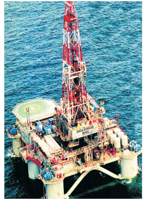
Плавучая буровая установка "Деде Горгуд".
