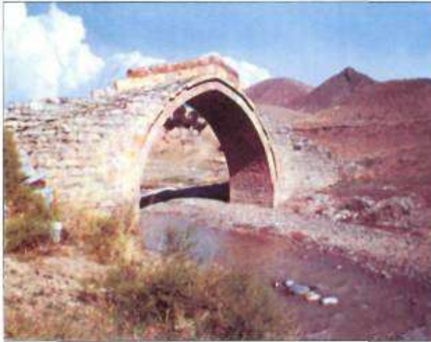
Qazançı körpüsü. XV-XVI əsrlər. Culfa rayonu. The Gazanchi Bridge. XV-XVI centuries. Julfa district.
