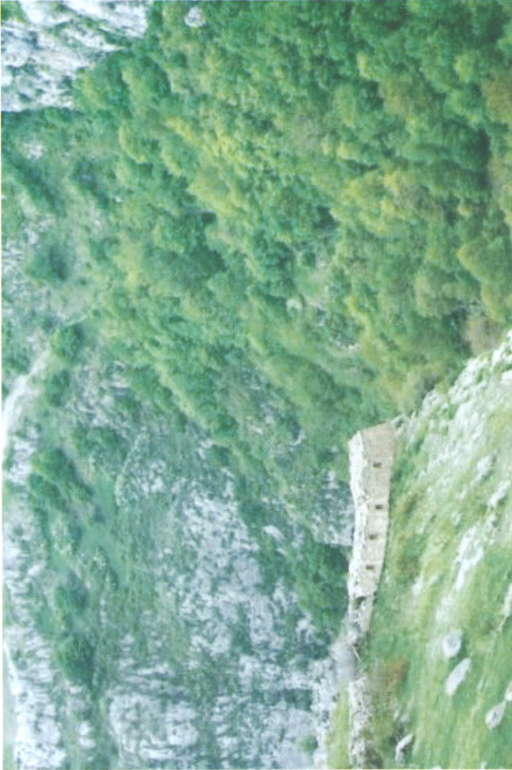
Şuşanın Potu ərazisində Qala divarının görünüşü
