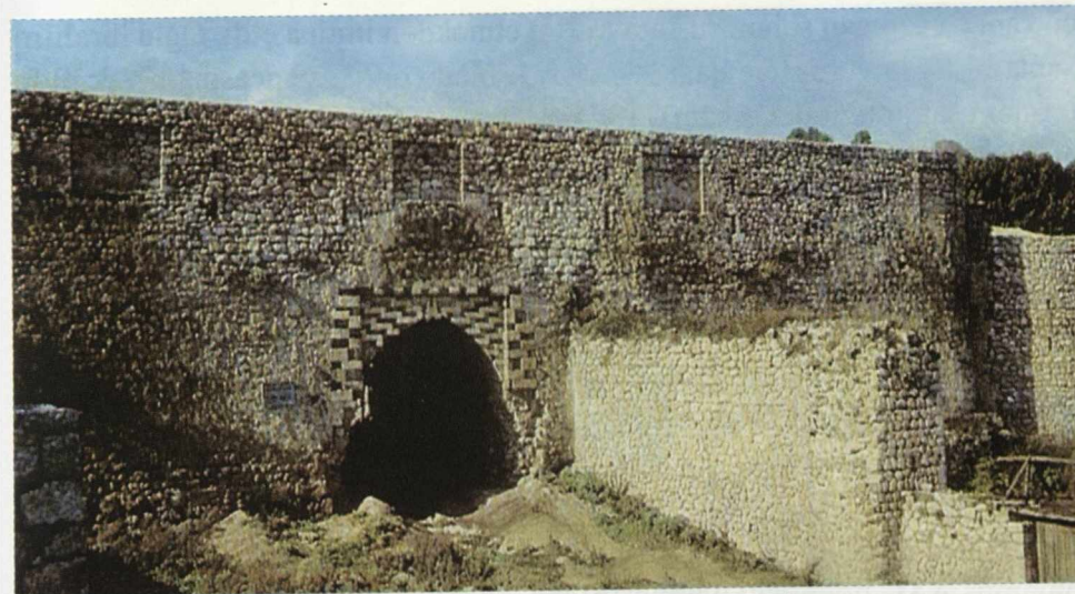
Gəncə şəhərinin qədim qala hasarları və qapısı
