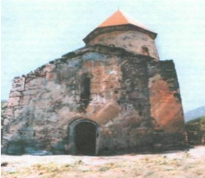
Şəki rayonu Kiş kəndində qədim Alban kilsəsi
