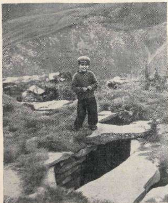
Каменные межэтажные перекрытия и развалины дома сел. Бурии Лакского района:
