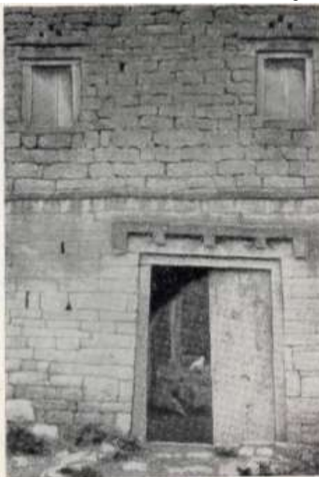
Часть фасада с деревянными ставнями в оконных проемах и бойницами. Дом Г. Магомедова («Данди-Балхарского») в сел. Балхар Акушинского района
