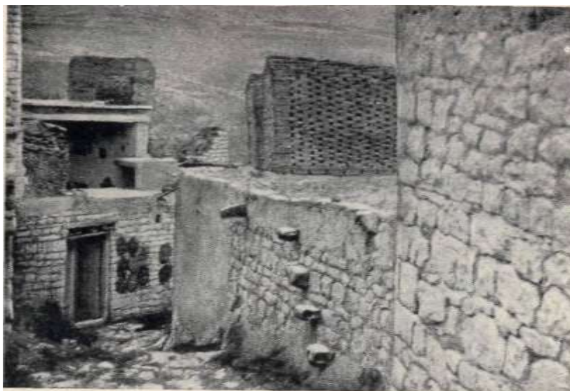
Наружная лестница в стене дома. Сел. Балхар Акушинского района
