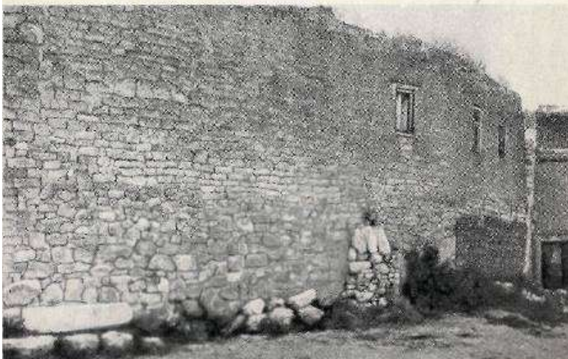
Контрфорс стены дома Г. Магомедова («Давди-Балхарского»)
