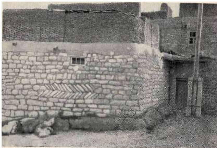
Антисейсмическая кладка «елочкой» в стене нового дома. Сел. Балхар Акушинского района.
