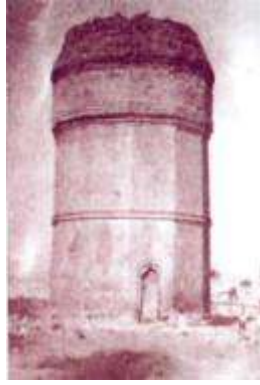
Cəfərabad//Pir Hüseyin türbəsi gümbəzi dağılmış halda.
